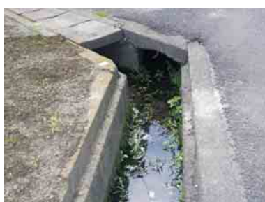
土砂の堆積しやすい側溝
