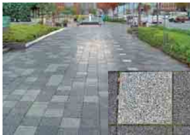
歩道部の透水性舗装
