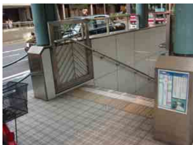
地下の出入口
