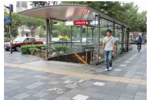
地下施設の出入り口
