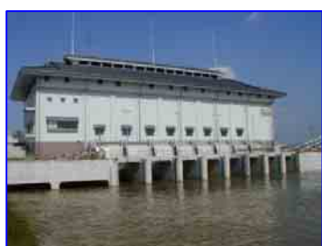
巨椋池排水機場
