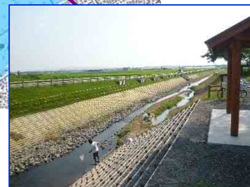
排水幹線水路
