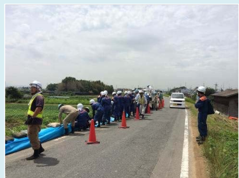
水防団・消防団による土のう積みの状況 (伏見区久我地区)
