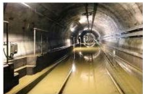
浸水した地下鉄東西線のトンネル部
