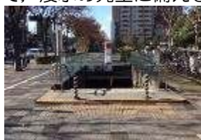
地下街等への出入口 (ゼスト御池)
