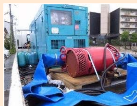
仮設ポンプによる応急浸水対策 (左: 設置状況, 右: 設置したポンプ(径200×2基))
