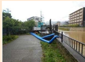
仮設ポンプによる応急浸水対策 (左: 設置状況, 右: 設置したポンプ(径200×2基))
