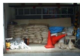
水防資器材の保管 (京都駅前地下街ポルタ) (写真: 京都ステーションセンター(株))
