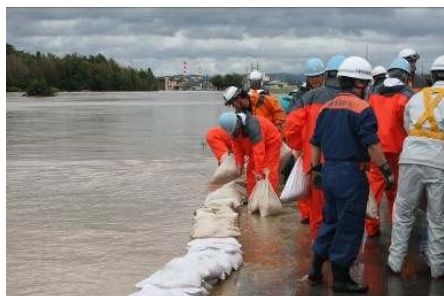
堤防に土のうを積み、嵩上げすることで 越水による浸水被害を軽減・防止
