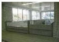
止水板の設置
