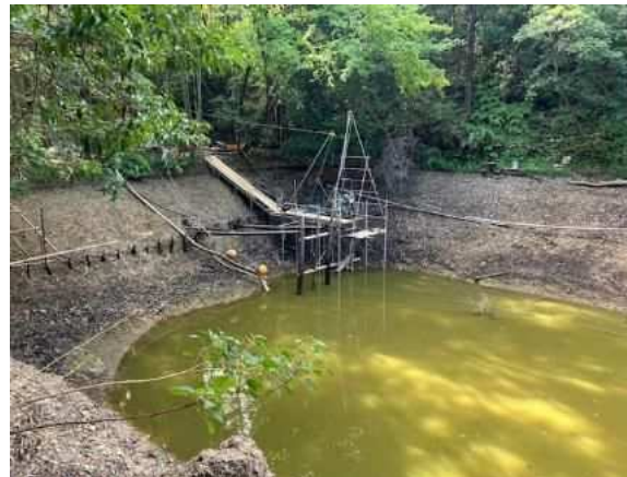
実施設計業務（ボーリング調査）の様子
