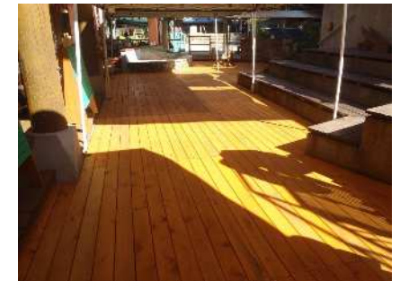
令和7年度実施: 民間建物等 (夢窓幼稚園)
