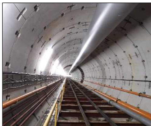
鳥羽第3導水きょ シールド工事管内 施工状況
