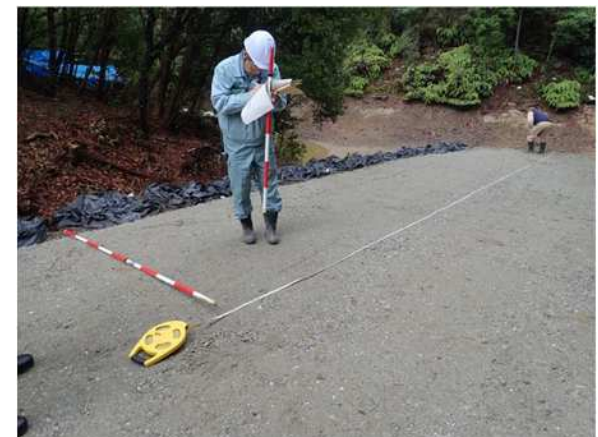
令和7年度防災工事の様子（仮設道路工）
