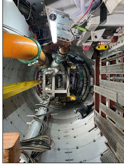
鳥羽第3導水きよシールド工事施工状況
