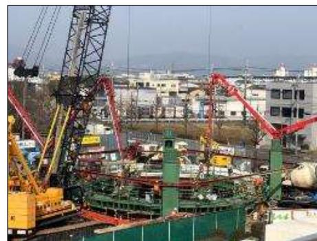
（参考）建造中の鳥羽第3導水きょの発進基地
