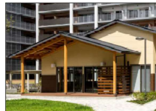
木造の事例 (市営住宅集会室)
